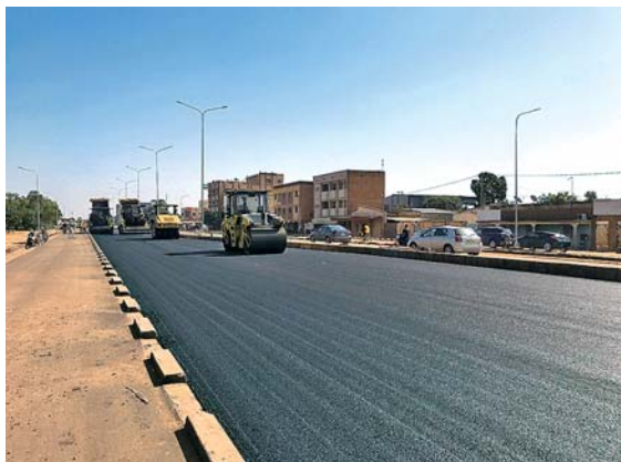
2班体制による舗装施工状況
